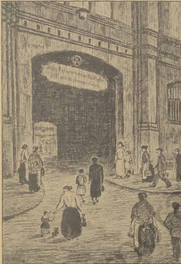
Mittag am alten Verwaltungsgebäude der Union Zeichnung von Paul Nowak, Dortmund, Union, Weichenbau
