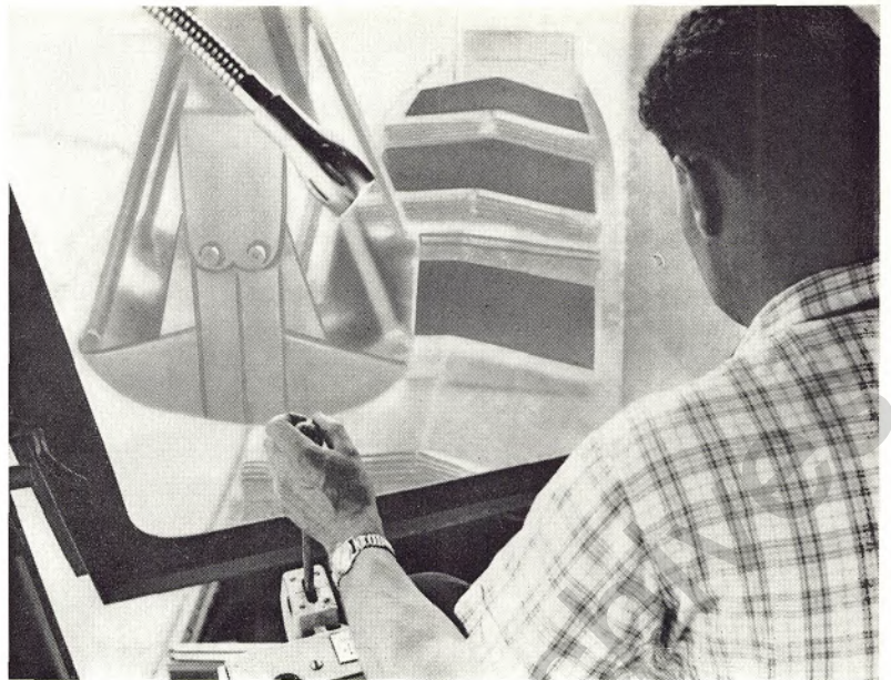
Oben: Der Kranführer der Schiffsentlade-Anlage bedient von seinem über das Wasser hinaus ragenden Steuerstand den Greifer, der mit jedem Hub zwölf Tonnen Erz in einem Bunker fördert (unten links), aus dem das Erz in gleichmäßigem Fluß über ein Plattenband (Mitte) der Bandanlage übergeben wird. Das Bild unten rechts zeigt den Verteiler Nord, von dem aus drei Bänder zur Eckstation West (im Vordergrund) und von da zum Erzlager bzw. zur Erzbrech- und -Siebanlage führen
