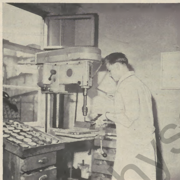
Anbohren der vom Stahlwerk geschickten Proben
