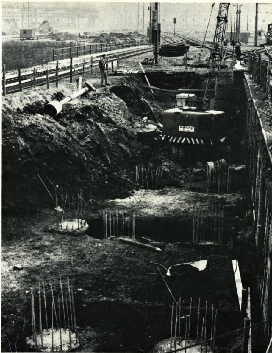
Ein Blick in die Baugrube. Auf den sichtbaren Pfahlköpfen ruht das ganze Fundament der Gleiswaage.
