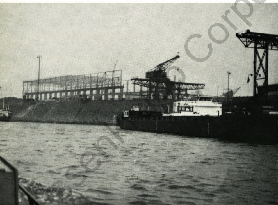
▼ Die in Bau befindliche Stahlkonstruktion vom Rhein her gesehen.
