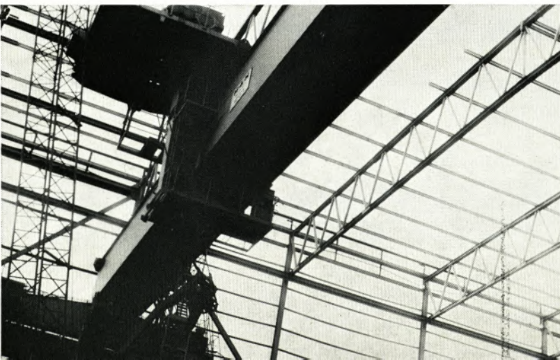
◀ Blick vom Lagerplatz auf den Einträgerkran mit Winkelkatze.
