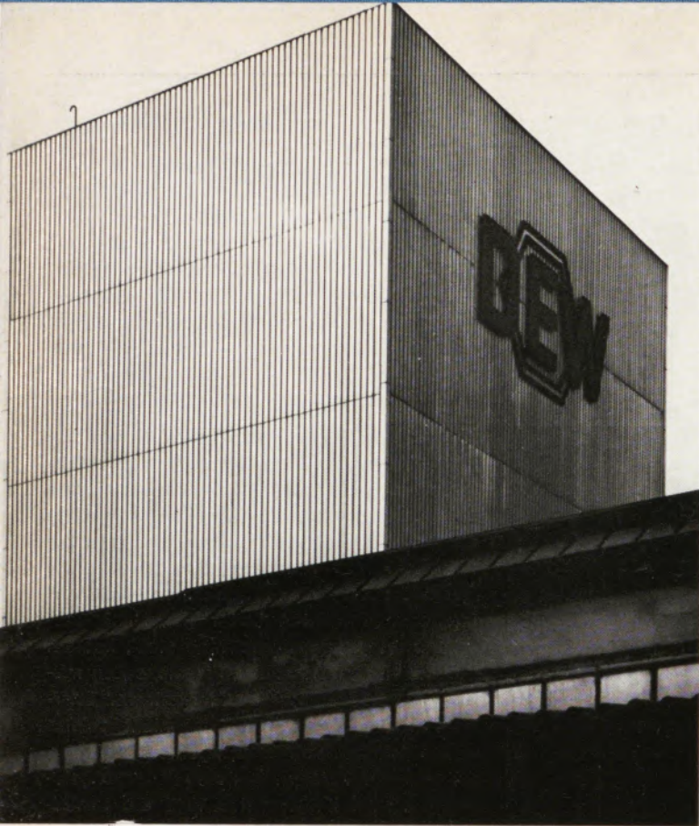
Turm der Blankglühanlage für Remanit-Kaltbreitband
