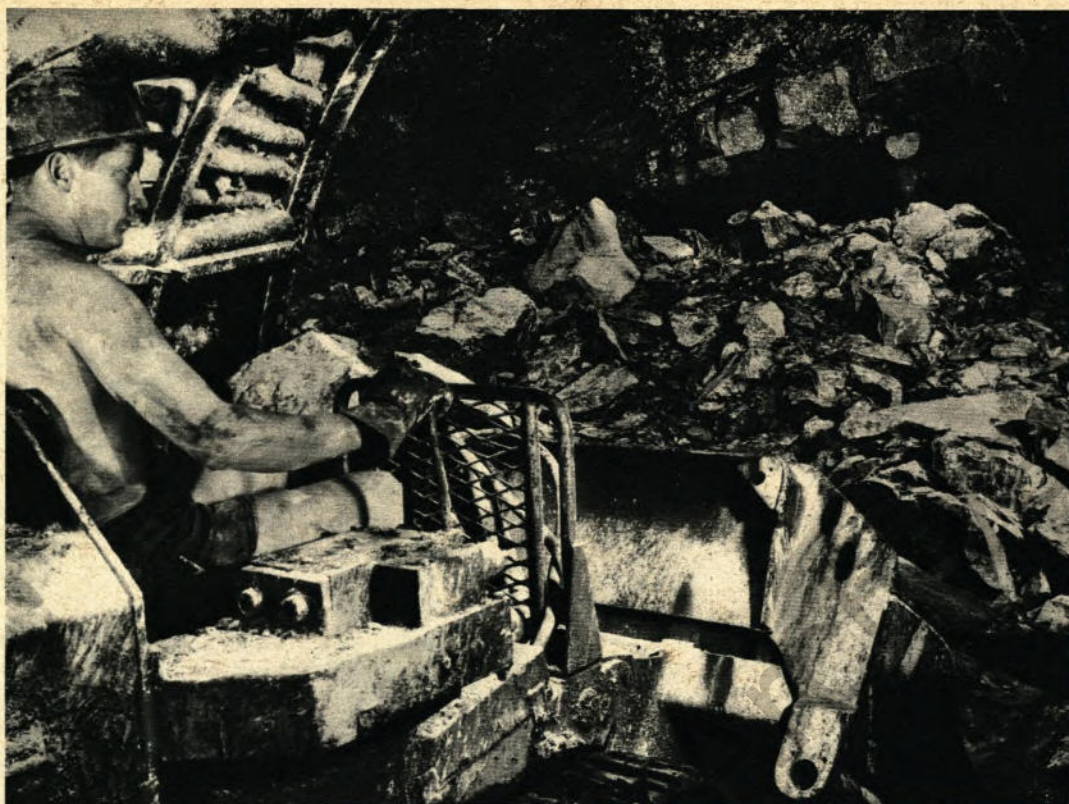
▲ Eine Strecke wird auf unserer Schachtanlage Radbod unter Tage vorgetrieben. Die losgeschossenen „Ausrichtungsberge“ schafft Willi Tomsar mit seinem Rau- penlader fort
