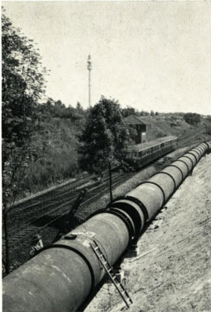
Titelseite: Mehr als zwei Meter mißt der äußere Durchmesser dieser schraubenlinien-nahtgeschweißten Rohre unseres Werkes Barop, die als Gichtgasleitung das Werk Hörde mit dem Werk Dortmund der Dortmund-Hörder Hüttenunion verbinden. Unsere Aufnahme entstand in der Nähe des Westfalenparks an der Stadtbahnlinie Hörde-Dorstfeld unweit des Fernsehturms
