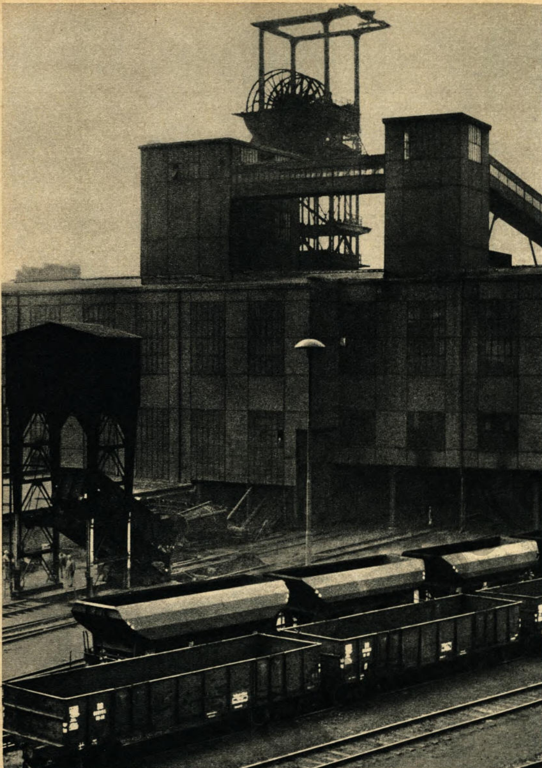
◀ Dieses Bild faßt die Übertageanlagen der Bergewirtschaft zusammen. Im Vordergrund ist die Waggonkippe sichtbar, in dem Gebäude dahinter sind Sieb und Brecher untergebracht. Der Turm links ist der obere Teil des Hochbunkers, der 500 Tonnen Berge faßt
