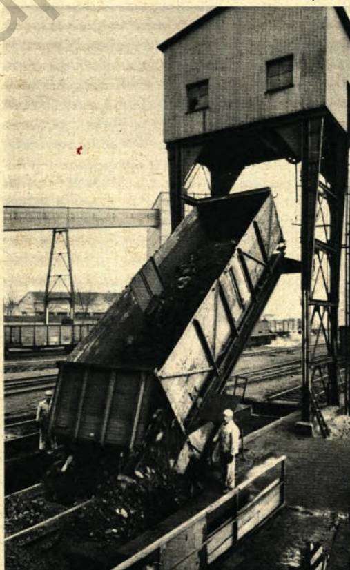
▲ Aber nicht nur unter Tage, auch über Tage fallen Berge an. In ununterbrochenem Strom kommen sie von der Wäsche, wo sie in Setzmaschinen von der reinen Kohle getrennt worden sind
