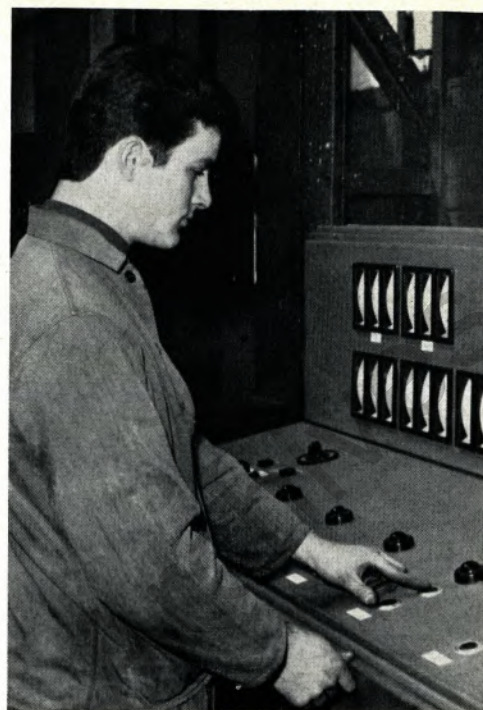
Die fertige Maschine wird auf dem Prüfstand zum Probelauf gebracht; hier kontrolliert der Lehrling am Schaltplan die richtige Stromaufnahme
