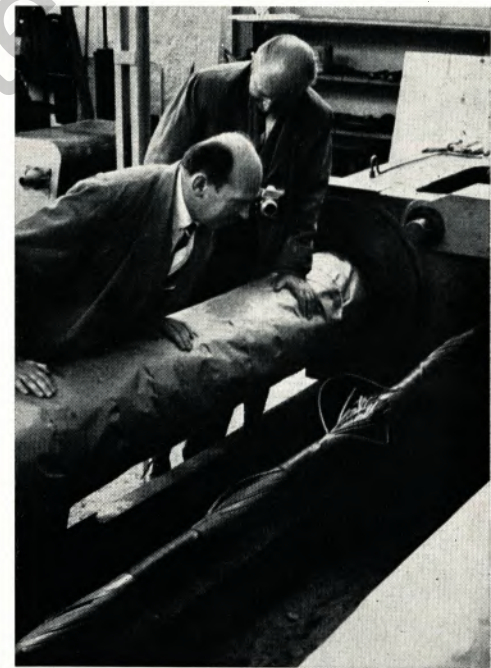
Die Bruchstelle sagt dem Fachmann viel; sie wurde deshalb von den verantwortlichen Brückenbau-Ingenieuren sehr genau besichtigt und im Bild festgehalten.
