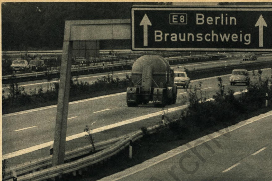
▲ Eines der fünf von Hoesch gebauten Häuser für die Verkehrspolizei Niedersachsens liegt am Autobahnkreuz östlich von Hannover. Unser Bild zeigt den Knotenpunkt mit dem Stützpunkt von Norden
