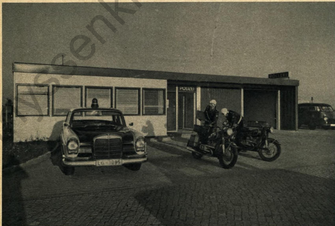
◀ Die Frontseite des Polizei-Stützpunktes aus Normbauteilen des Hoesch-Bungalows läßt die klaren Formen und die Raumaufteilung erkennen: links hinter der Fensterreihe liegt der Wachraum mit anschließendem Schreibzimmer und Aufenthaltsraum, rechts vom Eingang mit Windfang die Doppelgarage
