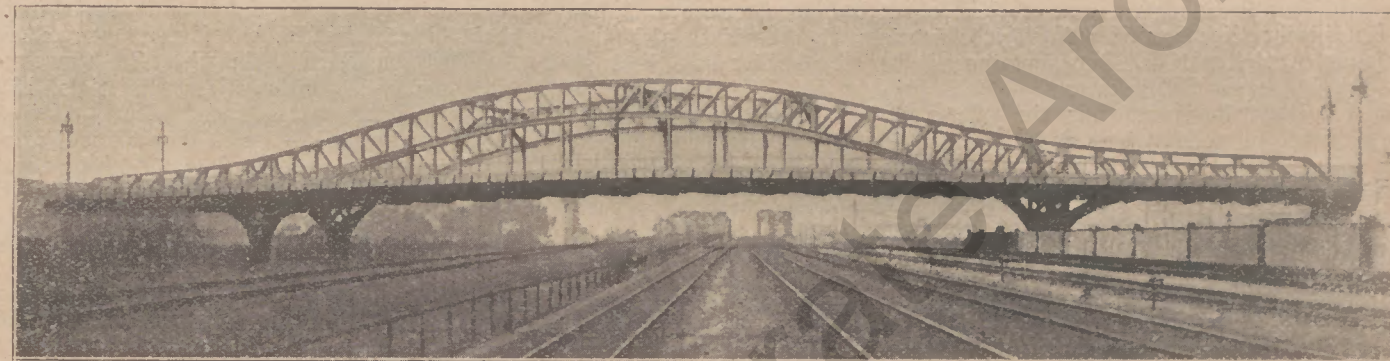
Die fertiggestellte Vornholmerstrassen-Brücke in Berlin (Hindenburgbrücke); Länge 138,0, Breite 27,0 m, Gewicht 1677 to, Baujahr 1913/14.
