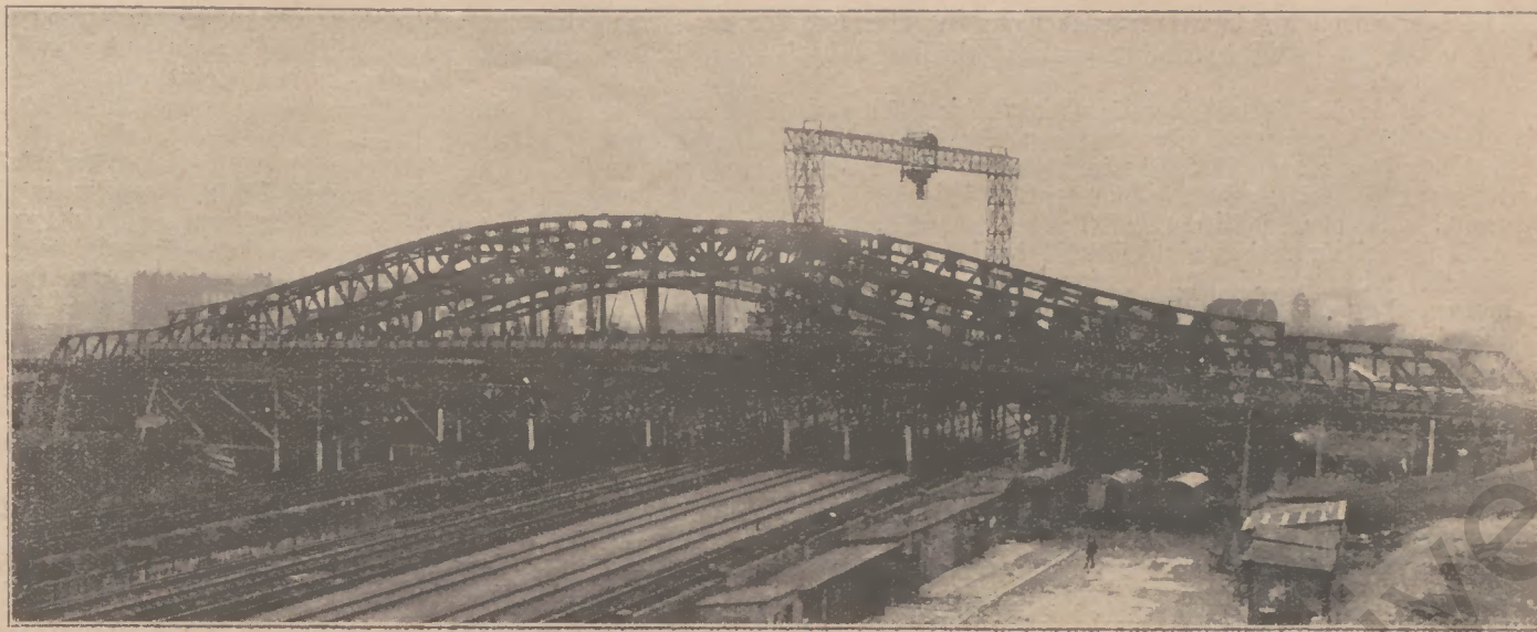
Die Vornholmerstrassen-Brücke in Berlin im Bau.
