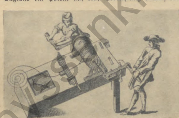
Abb. 8: Eisendraht-Handziehmaschine (Nach einem Stiche des 18. Jahrhunderts)
