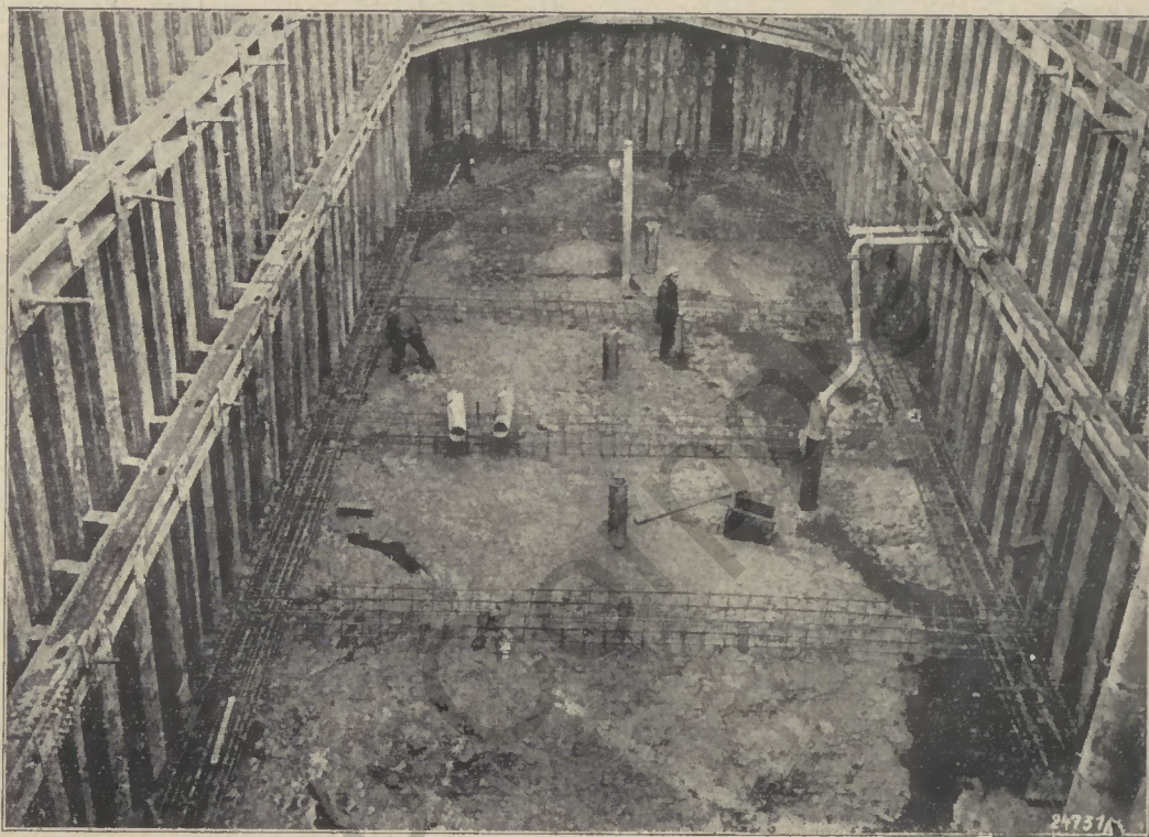
Schott 3. Außenhaupt (Beginn der Eisenverlegung)
