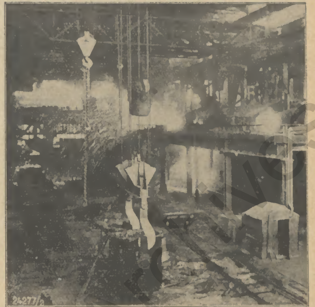
Im Thomasstahlwerk der August Thibissen-Hütte Hamborn
