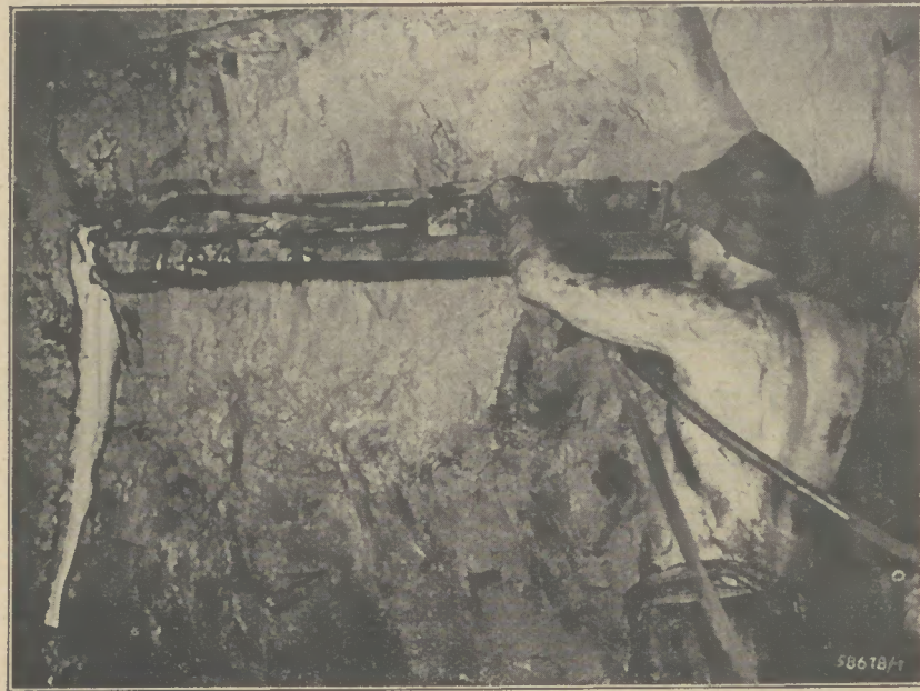
Anwendung des Schaumverfahrens beim Bohren
