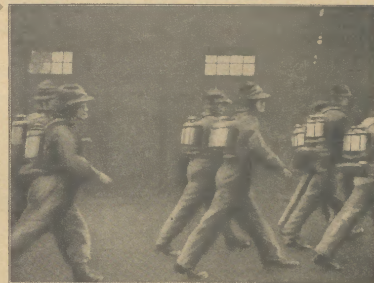
Abb. 2: Die Gasolonne auf dem Marsch zur Arbeitsstelle
