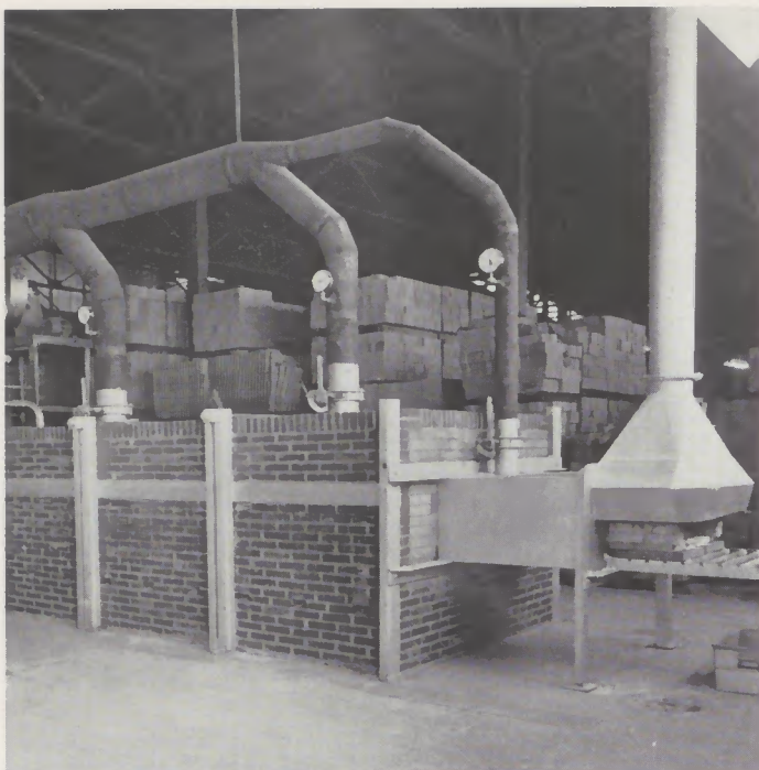
Schubofen in der Feinkeramischen Abteilung der Steinfabrik Dahlhausen
