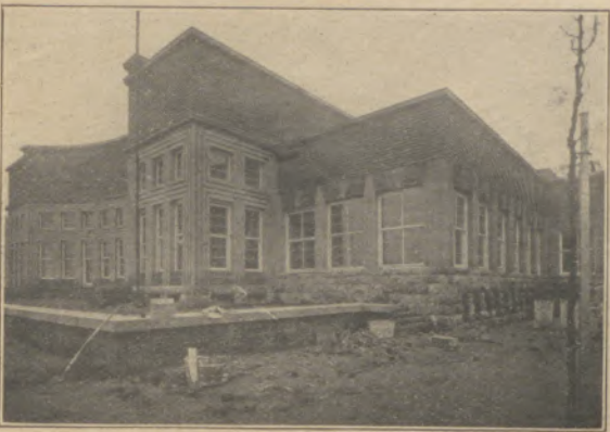
Das Rheinterassenrestaurant vor der Fertigstellung.
