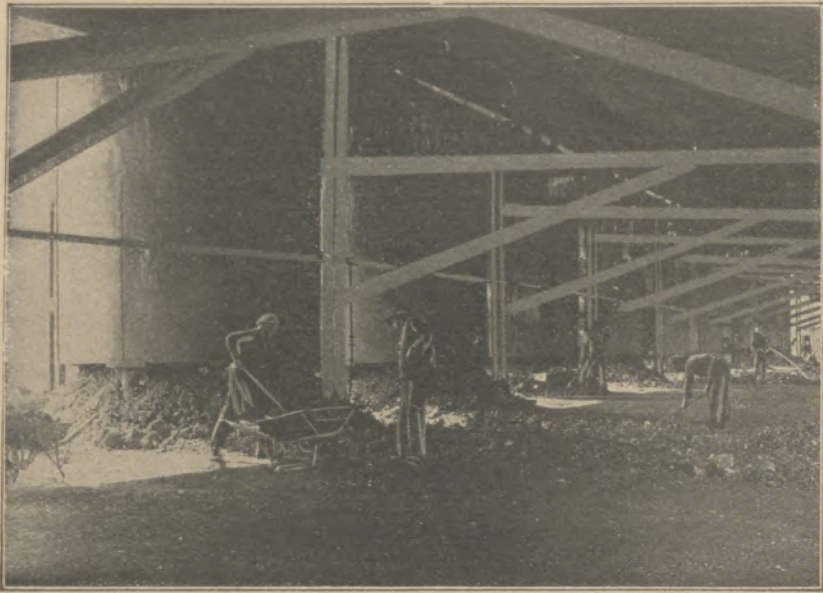
Teilansicht der Röstanlage einer Eisenerz-Zeche.
