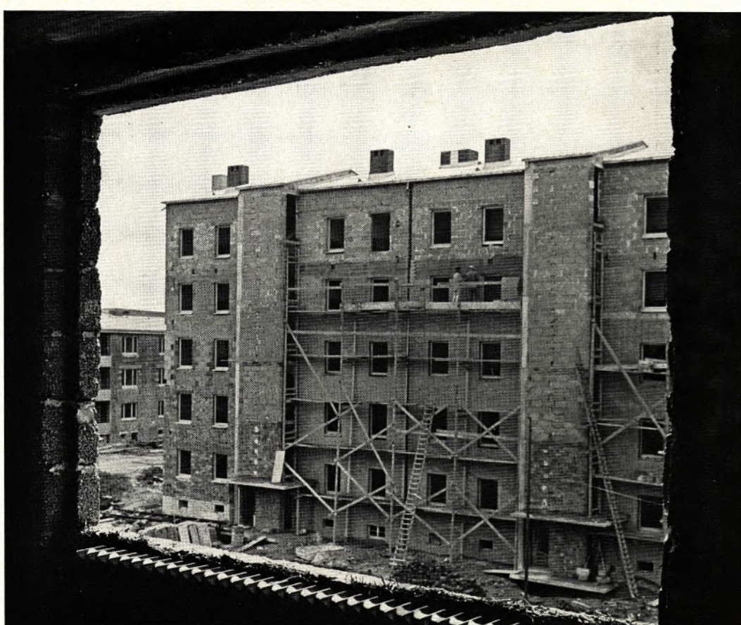
Baustelle Zinkhüttenplatz: Hier entsteht ein fünfstöckiges Wohnhaus, das hell verklankert wird
