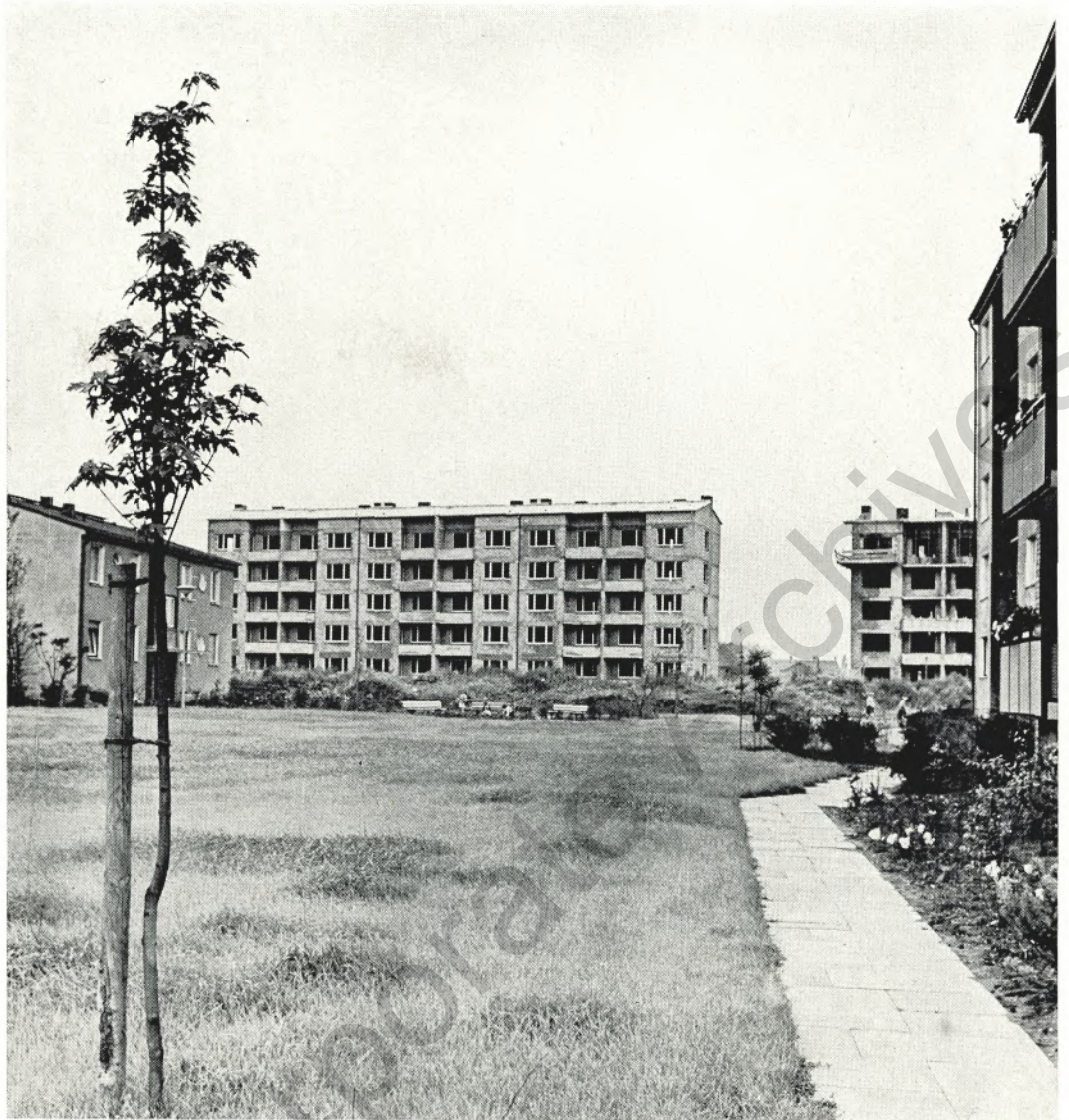
Wohnanlage Zinkhüttenplatz: Neben bereits bezogenen Häusern wachsen neue Bauten aus der Erde
