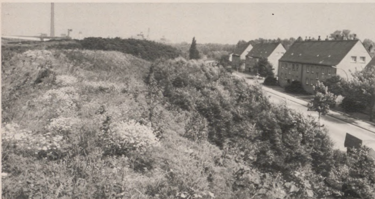
▲ Vielseitig sind die Maßnahmen zur Lärmbekämpfung: Zu ihnen gehören auch die schützenden Wälle an der Rüschelbrinkstraße, die die Bewohner der angrenzenden Wohnsiedlung vor dem Lärm der Sinteranlage 4 schützen
