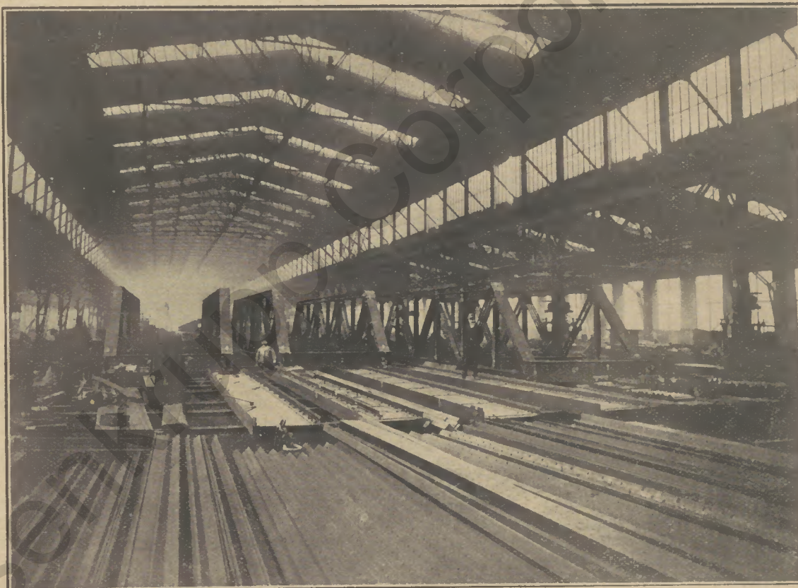
Blick in die Brückenbauanstalt der Dortmunder Union
