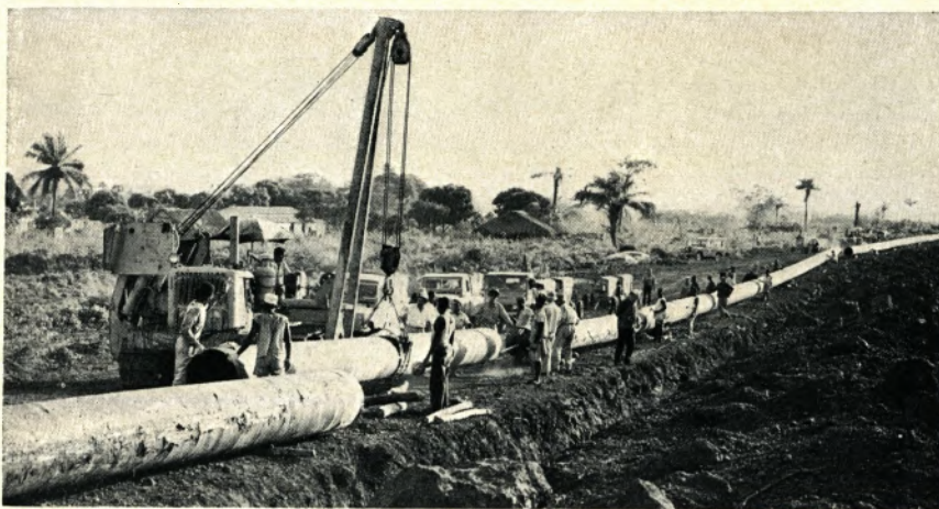
Eine neue Trinkwasserleitung für Conakry gehört zu den internationalen Großprojekten, die von der Arbeitsgemeinschaft Phoenix-Rheinrohr-International und Stahlunion-Export gebaut wurden. S. 20/23
