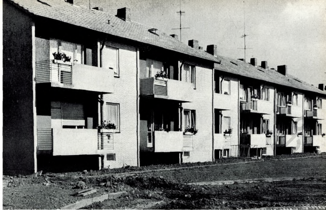
Die Klinker-Siedlung mit den jüngsten Werkswohnungen der August Thyssen-Hütte in Walsum. 62 Mietwohnungen sind bereits bezogen, weitere 44 im Bau. Alle Häuser erhalten eine Klinkerverkleidung
