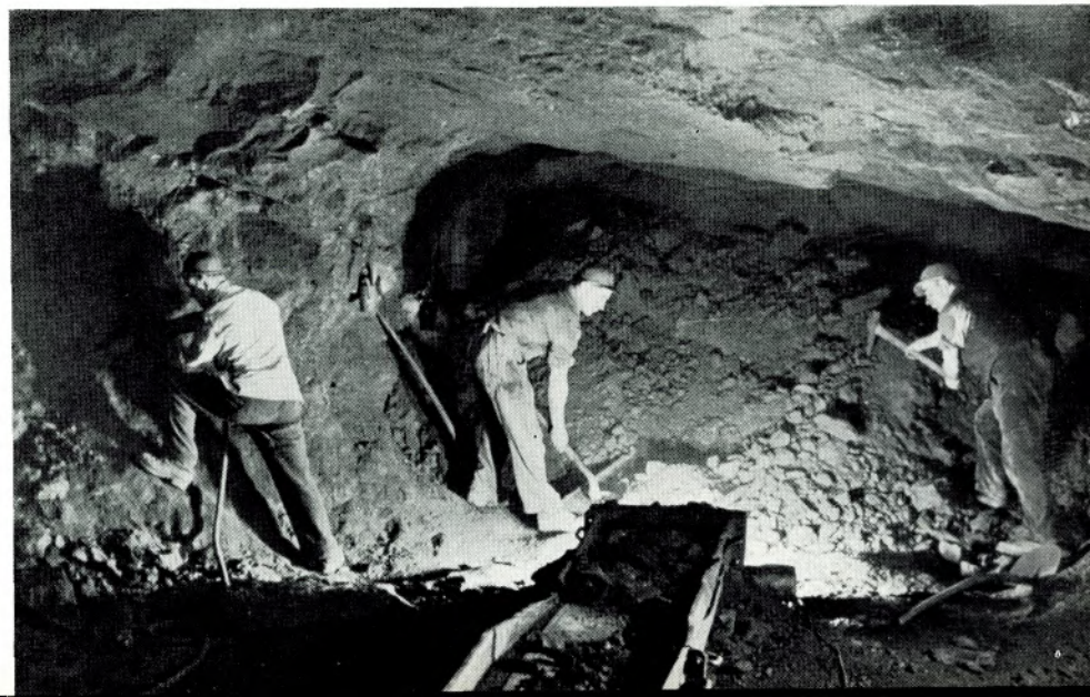
Drei Hauer unter Tage bei der Ladearbeit auf ein Förderband
