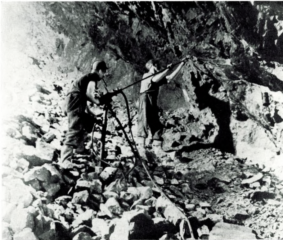
Zwei Hauer beim Bohren im Abbau unter Tage
