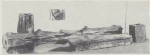
Abb. 18 Holzrohre für Wasserleitungen um 1770
