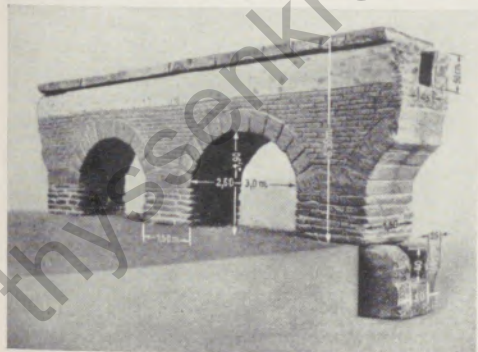
Abb. 13 Römische Wasserleitung zwischen Hermülheim und Köln. Die ältere dient als Fundament der jüngeren Hochleitung (Modellaufnahme Rheinisches Museum Köln)
