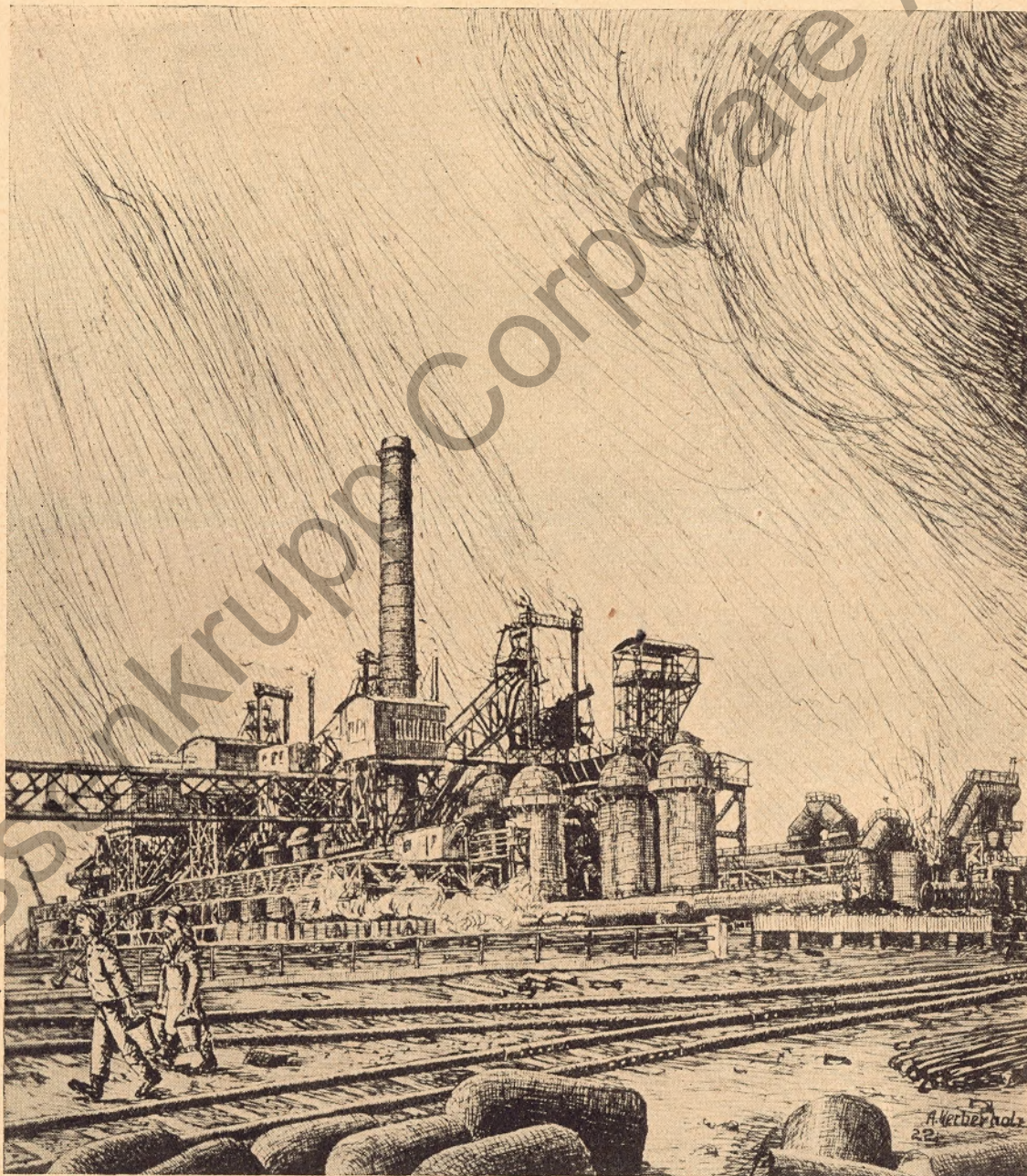
Bochumer Hochofen. Federzeichnung von Albert Herberholz, Blick von Südosten in die Ofenreihe. Links die 73 m spannende Erzladebrücke, unter ihr der 23-m-Rübelkran
