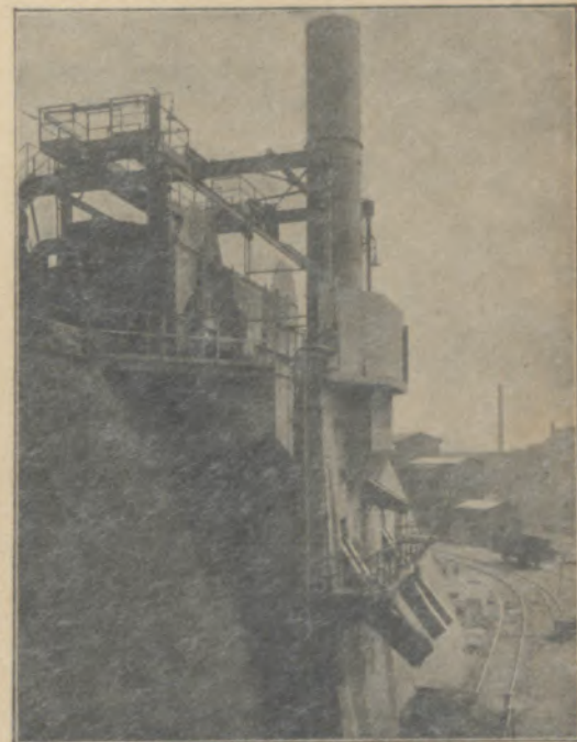
Bild 2: Anlage zur „Trockengranulierung“ der Hochofenschlacke
