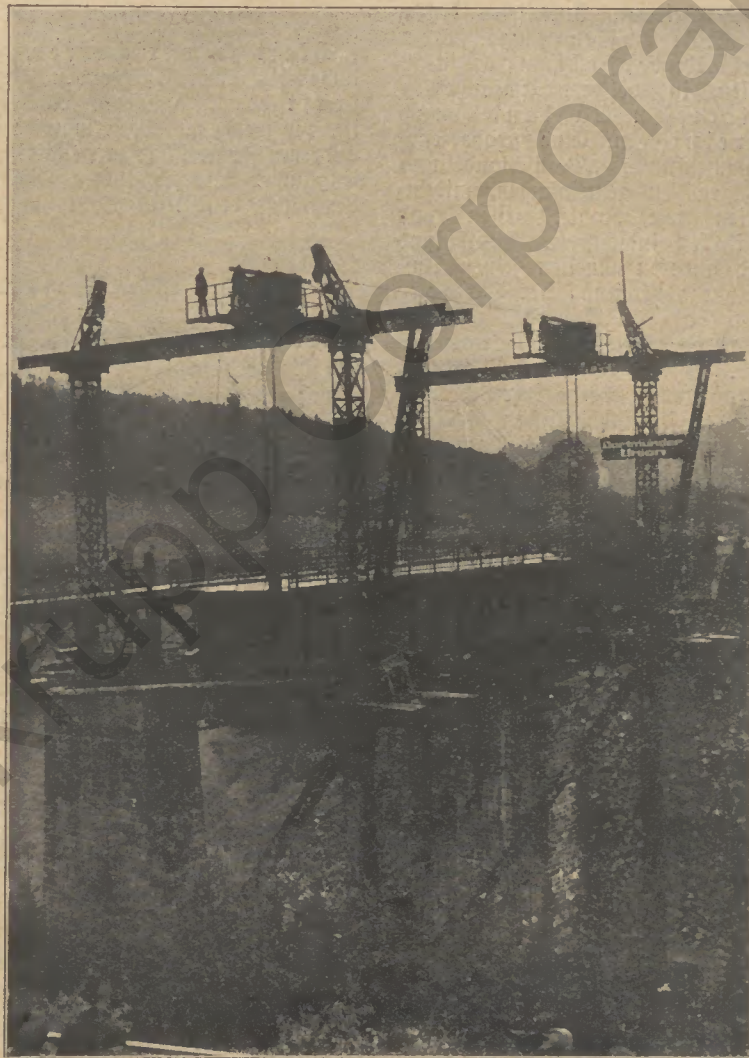
Die Auswechslung der Krähwinklerbrücke.
