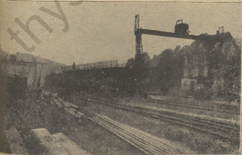
Die Brücke wird auf die Drehschemelwagen geschoben.
