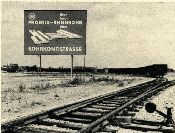
Mit dem Bau der neuen Rohrkontistramße in Mülheim ist inzwischen begonnen worden. Große Tafeln weisen Vorübergehende auf dieses Objekt hin.
