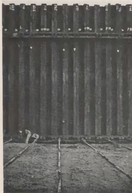
Rückseite: Bis zu 25,70 Meter lang sind die Hoesch-Spundbohlen, die im Hafen Bremen gerammt wurden. Damit sie die Last des Erdreichs aushalten, wurden sie mit einer parallel verlaufenden zweiten Spundwand verankert.
