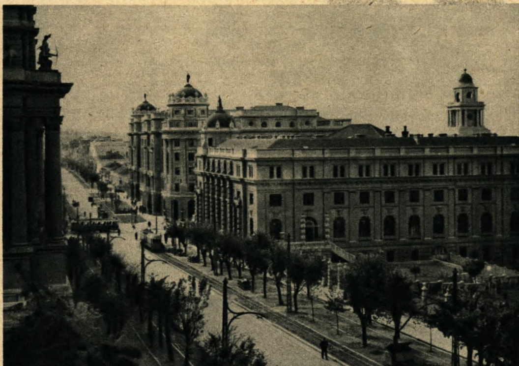
Blick auf das Ministerium für Forsten und Bergwerke und das Finanzministerium im neuen Belgrad
