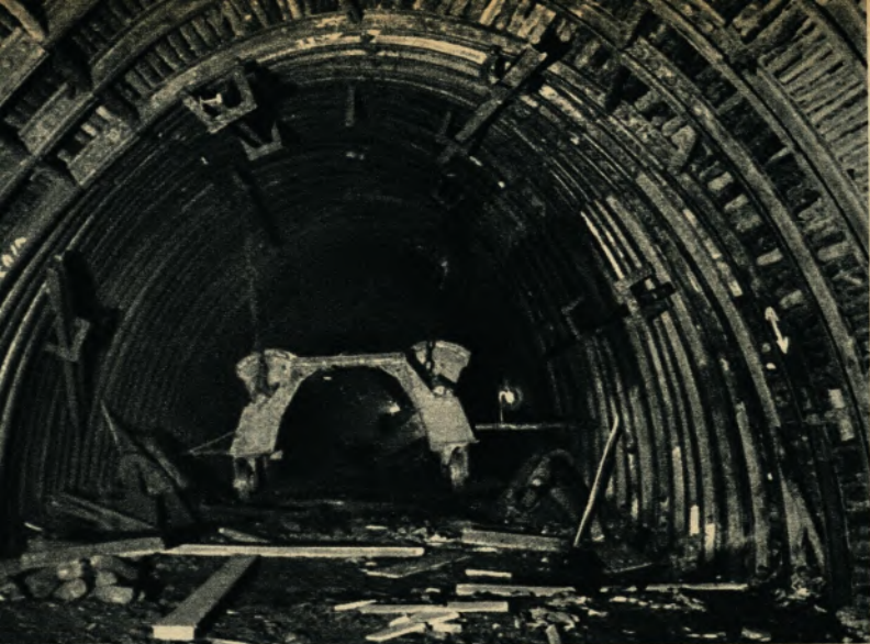
Wenige Tage nach dem Durchschlag: Die ausgebaute Durchbruchstelle
