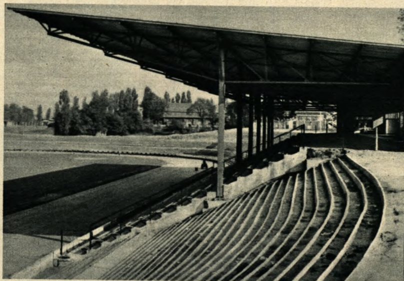
Die Tribüne des Sport-Clubs Preußen Münster, sie ist etwa 70 m lang und 26 m tief. Schon während der Montage bestand diese Konstruktion ihre Bewährungsprobe, als beim Spiel Schalke 04 gegen SC Preußen Münster die ganz Unentwegten das noch freie Stahlgerüst als „guten Platz“ wählten. Das untere Bild zeigt die Tribüne nach der Fertigstellung
