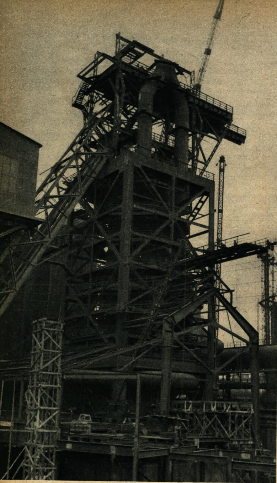
So sah der Bauzustand des Hochofens 6 der Westfalenhütte Anfang November aus. Um die Jahreswende soll der Hochofen in Betrieb gehen
