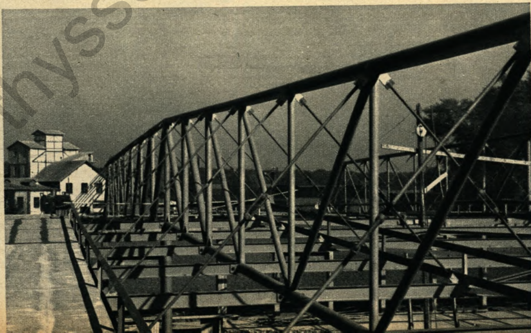
Gewaltig - mit 40 m Spannweite - streckt sich hier ein Röhrenbinder über die noch im Bau befindliche Halle der Glasuritwerke, Max Winkelmann AG., Hiltrop
