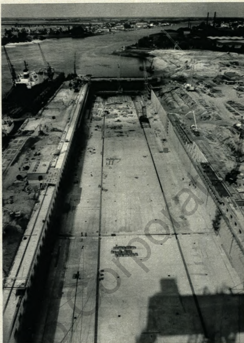
▲ Hoesch-Stahlspundwand sichert die zur Weser gelegene Wand der Dockkammer
