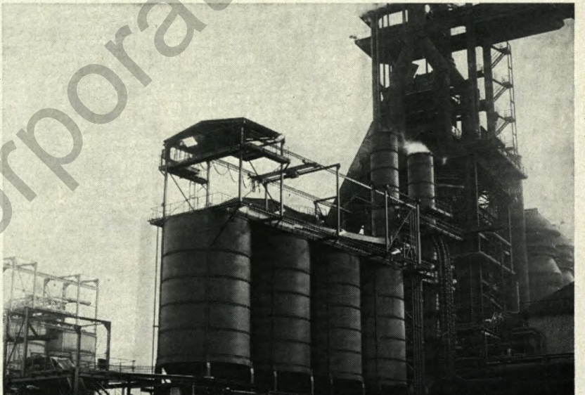
Die anfallende Hochofenschlacke wird in dieser Anlage am neuen Hochofen IV der Westfalenhütte mit Wasser zu Schlackensand granuliert, anschließend entwässert und über eine Lkw-Verladung als Zementrohstoff oder für Bauzwecke zum Versand gebracht.
