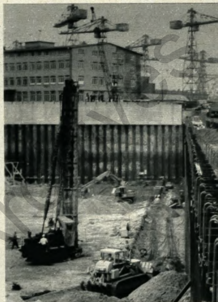
▲ Hoesch-Stahlspundwand sichert die zur Weser gelegene Wand der Dockkammer
