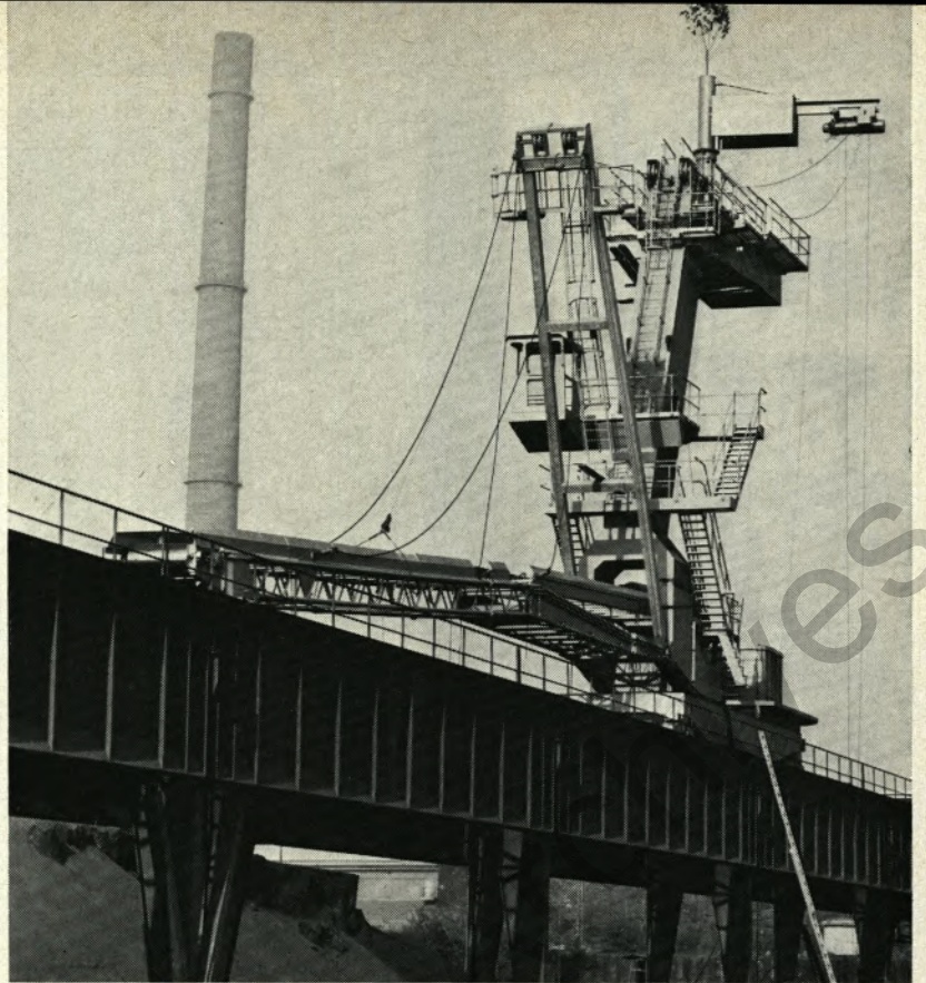
Eine Auflage des Gewerbeaufsichtsamtes, die aus Gründen des Umweltschutzes ergangen ist, macht die Stilllegung des Sinterbandes 2 erforderlich. Für das Sinterband 3 und das in der Planung befindliche Sinterband 4 wurde ein Schwenkabsetzer in Betrieb genommen, der Feinerze einlagert. Seine Auslegerlänge beträgt 35 m, die maximale Stundenleistung 1500 t.
