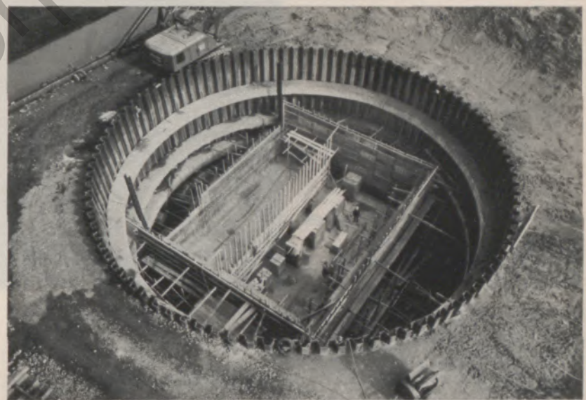
▼ Bau eines Pumpwerkes im Schutz einer Spundwand-Kreis-zelle (1)
