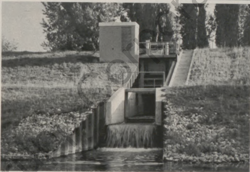
◀ Überleitungsbauwerk, durch das Rheinwasser bei Hamm in die Lippe geleitet wird (8)
