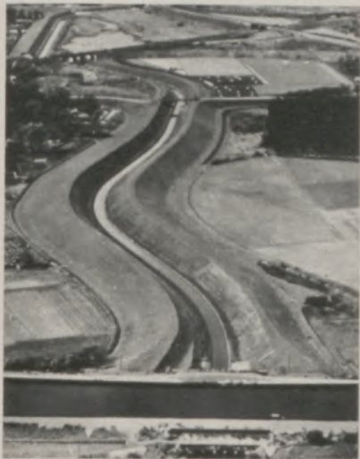
▲ Ohne Gefällreserven müssen Deiche das Bachprofil begrenzen; hier Deiche der Seseke in Lünen-Schwansbell (5)
