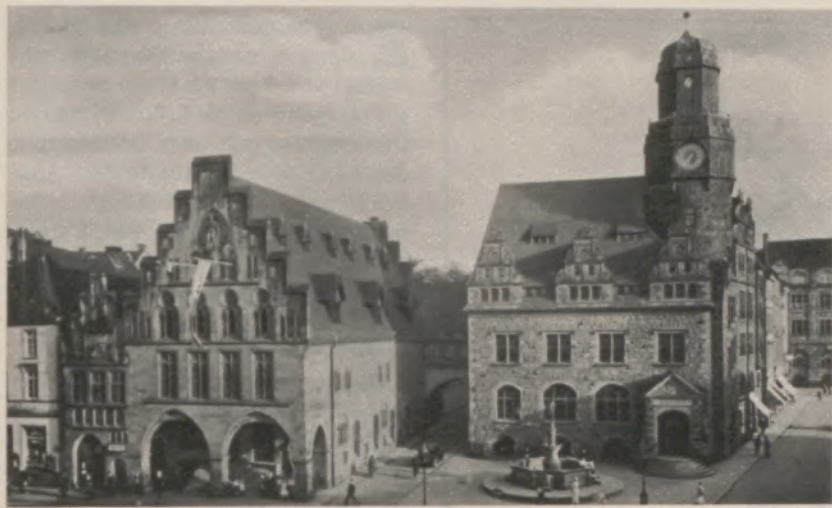
▲ Mit dem Abstieg Dortmunds verfiel auch das Dortmunder Rathaus aus dem 13. Jahrhundert. Erst 1899 wurde es „renoviert“ – so gründlich, daß der Dortmunder Agent es im General-Anzeiger „ein eigenes Kunstgemisch“ mit einem Dachim „Pfefferpotthaststil“ nannte
