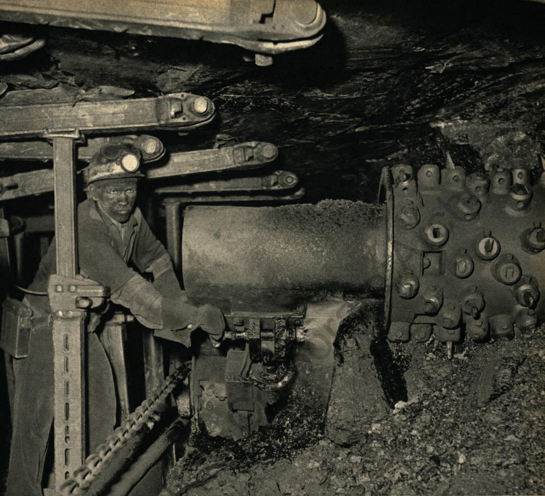
▲ Der Anteil des mechanisierten Kohlenabbaus stieg im Berichtsjahr von 65 v. H. auf 74 v. H. Unser Bild zeigt ein Beispiel vollmechanisierten Abbaus in flacher Lagerung. Hauer Lankowsky bedient 760 Meter unter Tage einen Walzenschrämlader, von dem die obere Walze vor der Kohle deutlich zu erkennen ist
