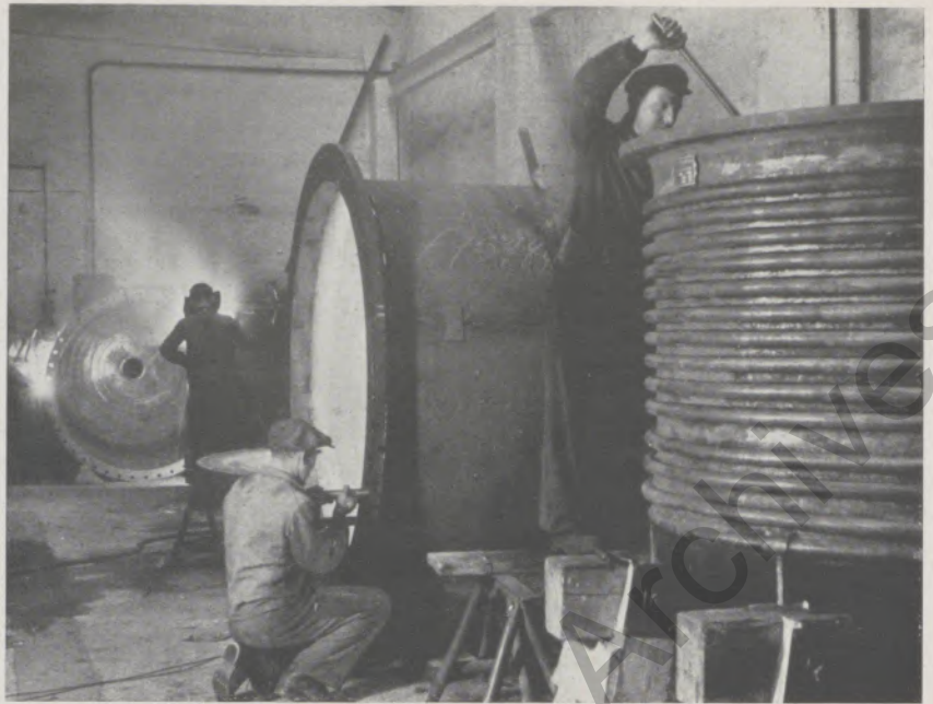
Bild 3: Werkstatt für remanentplattierte Kessel
