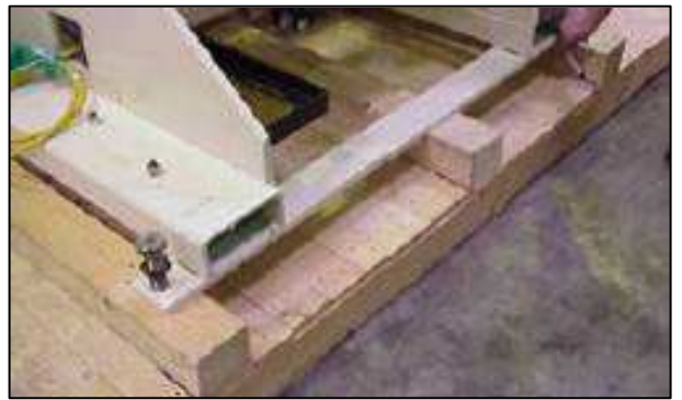
Die Maschine ist aufgesetzt. Die Positionen der Lagerhölzer werden markiert.
