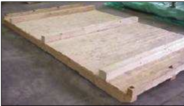
Bereitstellen der Plattform mit aufgelegten Lagerhölzern
