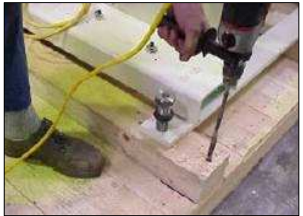
Die Bohrungen der Befestigungsbolzen und Bolzenbohrungen der Lagerhölzer werden gebohrt.
