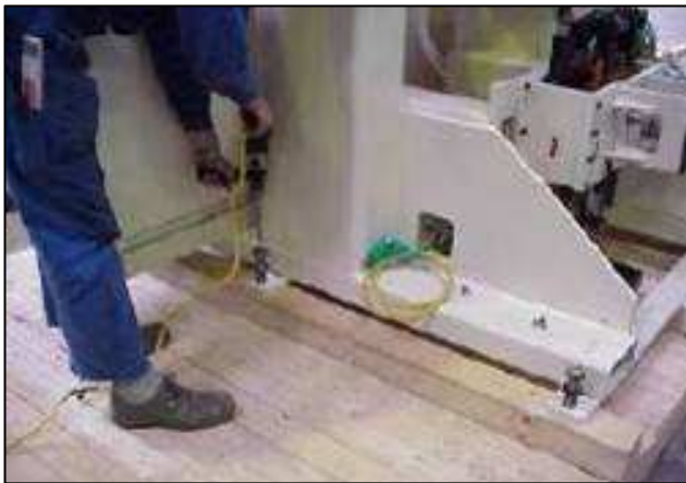
Die Bohrungen der Befestigungsbolzen und Bolzenbohrungen der Lagerhölzer werden gebohrt.
