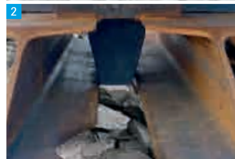
1: Uzel upevnění kolejnice 2: Hmoždinka
