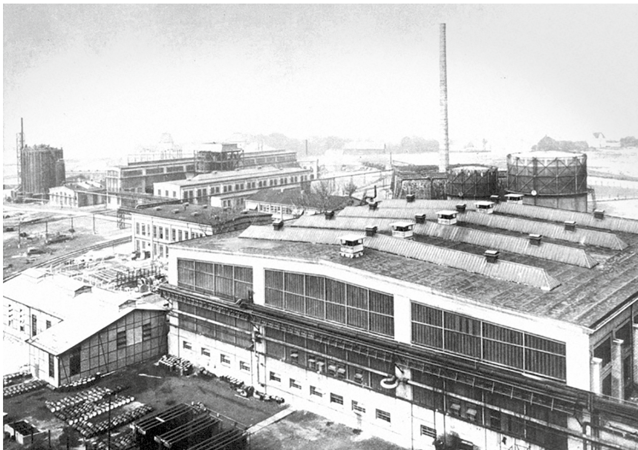
The first ammonia plant to use the Mont-Cenis-Uhde process has a production capacity of 100 metric tons/day and goes into operation in 1928 (Mont Cenis Colliery, Herne). The entire risk associated with this plant rests solely on Friedrich Uhde's shoulders. By 1937, 28 of these plants have already been sold worldwide. | Die erste Ammoniak-Anlage nach dem Mont-Cenis-Uhde-Verfahren umfasst eine Produktionskapazität von 100 Tonnen/Tag und geht 1928 in Betrieb (Zeche Mont Cenis, Herne). Das gesamte Risiko in Verbindung mit dieser Anlage lastet allein auf Friedrich Uhde. Bis 1937 werden weltweit bereits 28 dieser Anlagen verkauft.
