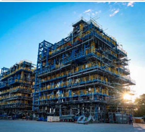
Top left: the polyol process units on the construction site in Thailand; bottom right: fully assembled in Hungary. Only a limited time window is available for transport by river. A masterpiece of engineering and project logistics. | Links oben die Polyol-Prozesseinheiten auf dem Baufeld in Thailand, unten rechts fertig aufgebaut in Ungarn. Für den Transport ist auf den Flüssen nur ein begrenztes Zeitfenster verfügbar. Ein Meisterstück an Ingenieurskunst und Projektlogistik.
