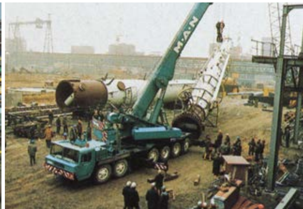
Erection of the VC columns with the aid of a 600-t truck-mounted crane | Arbeiten zum Aufrichten der VC-Kolonnen mit einem 600 t Autokran
