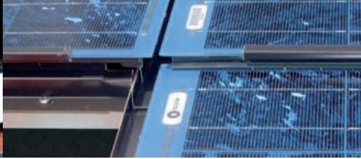
Plaatsing onder FV panelen.
