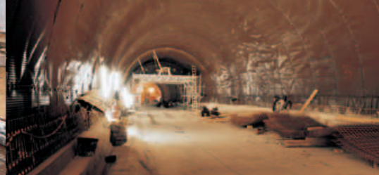
Doeltreffende drainage bij tunnelbouw.
