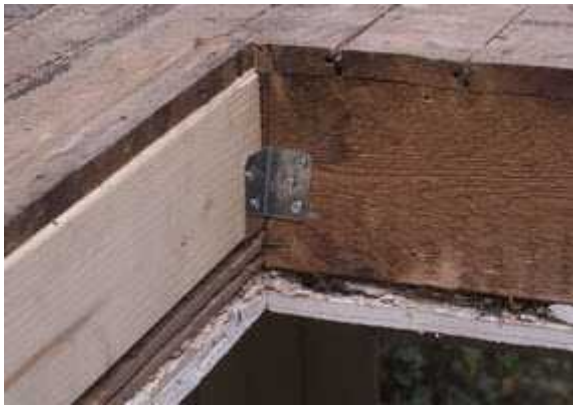
Stap 5: Aanbrengen hulpconstructie (raveling)
