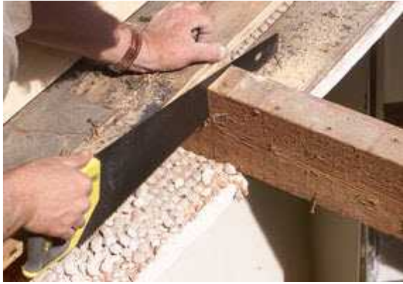
Stap 4: Uitzagen van de balkenconstructie
