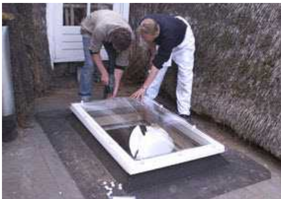
Stap 9: Koepel wordt op de opstand gemonteerd
