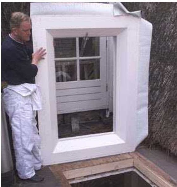
Stap 6: Aanbrengen kitrand
