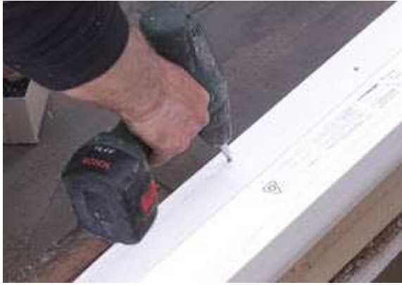
Stap 7: Vastschroeven van de opstand
