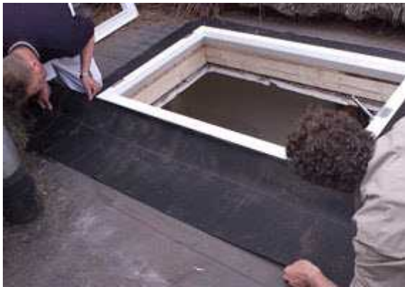
Stap 8: Aanbrengen dakbedekkingsmateriaal
