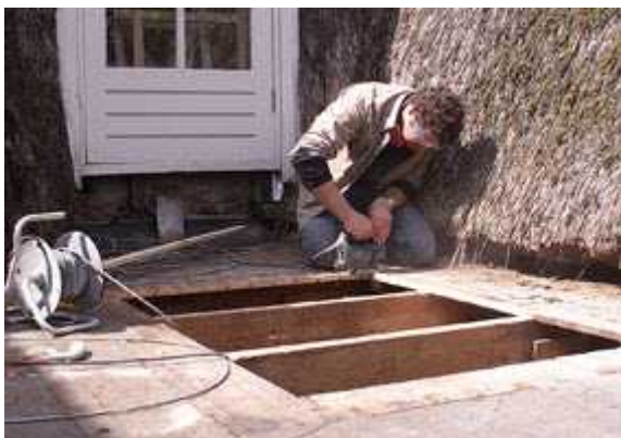
Stap 3: Het gat in het dak wordt uitgezaagd
