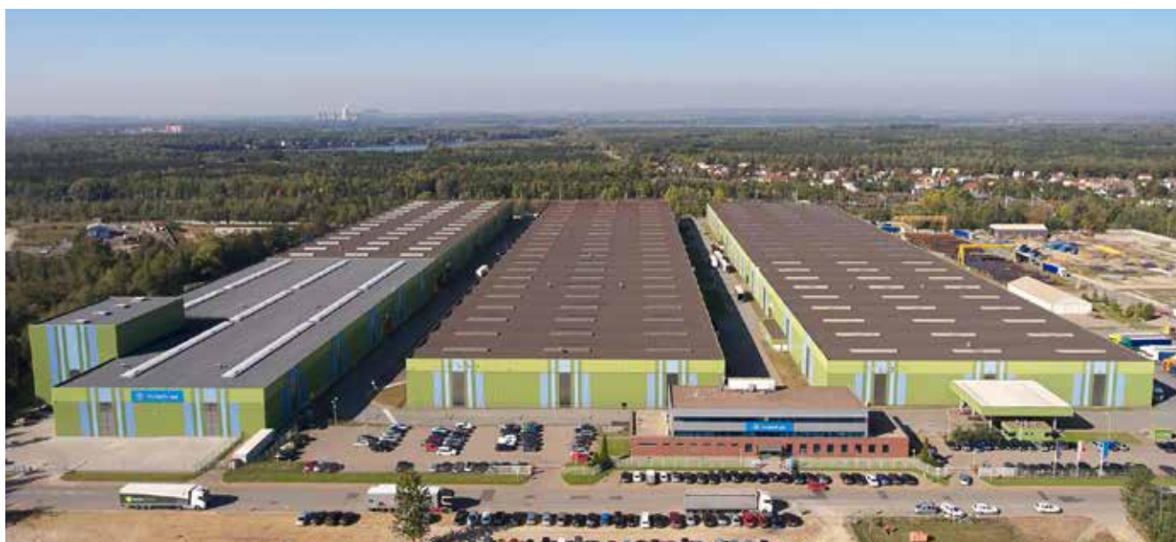
Centrum magazynowo-serwisowe w Dąbrowie Górniczej
