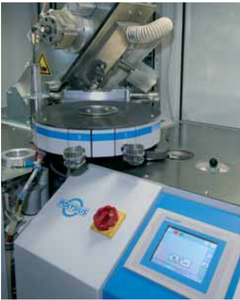
Estación automática de recepción de correo neumático ...
