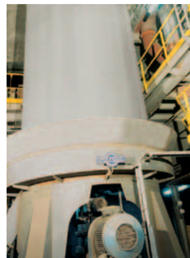
Antriebseinheit des Feingutkühlers.
