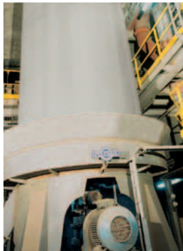
Groupe de commande du refroidisseur à matières pulvérulentes.
