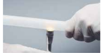
Mit der vor-Ort-Prüfung der Schweissqualität endet der ganzheitliche Qualitätsprozess.
